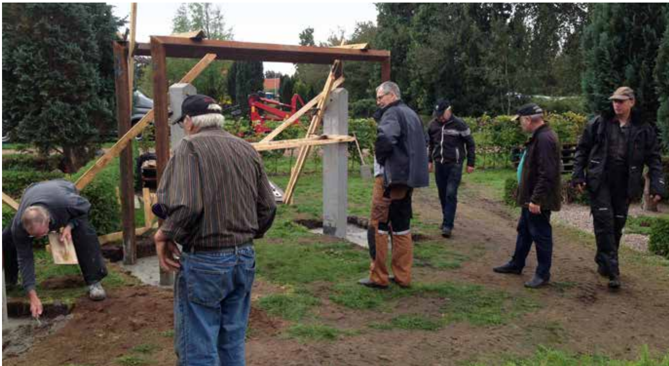
Fundamenterne støbes under kyndig vejledning af holdets murer.
